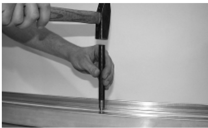
Abb. 5 Einschlagen des Belüftungsrohrs Fig. 5 Enfouissement du tube de ventilation
