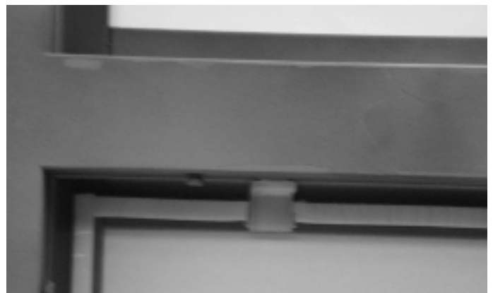
Abb. 10 Freistellung Distanzband beim Belüftungswinkel Fig. 10 Interruption de la bande d'écartement sur l'équerre de ventilation
