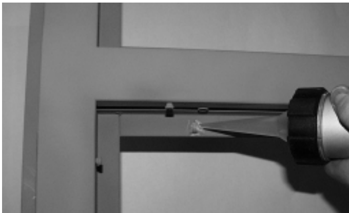
Abb. 7a Abdichten lappenseitig Fig. 7a Etancher côté battue
