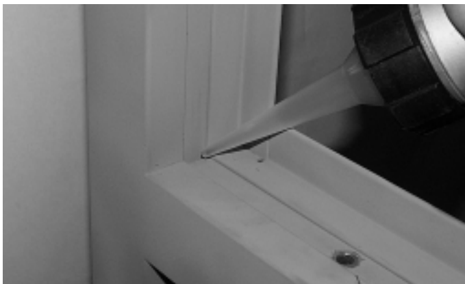
Abb. 9 Abdichten Ecken- und T-Stoss Fig. 9 Etanchéité des joints d'angle et en T
